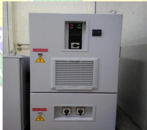
Gambar 2. 30 CCR PAPI Sumber : UPBU A.P.T. Pranoto Samarinda
