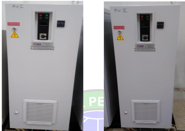
Gambar 2. 29 CCR R/W I dan R/W II Sumber : UPBU A.P.T. Pranoto Samarinda
