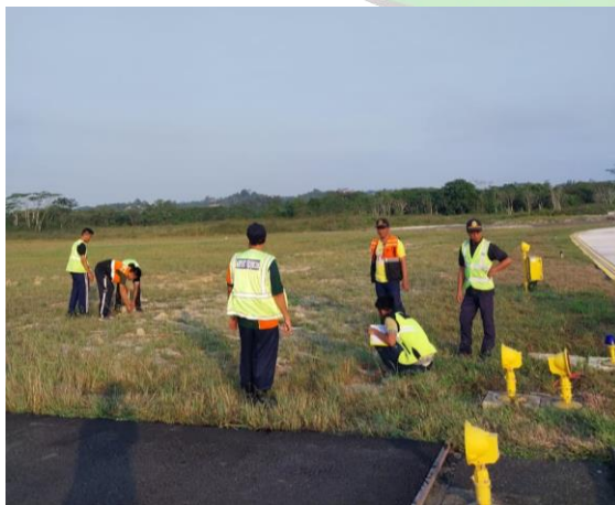
Pengukuran jarak antar lampu di runway
