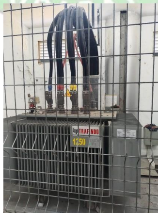
Gambar 2.5 Trafo 1250 kVA
