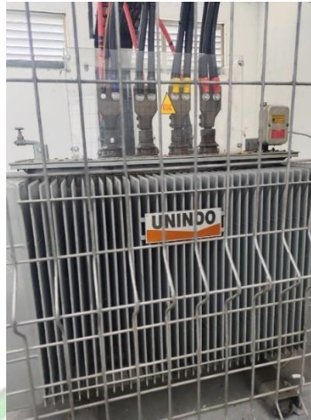
Gambar 2.6 Trafo 1600 kVA
