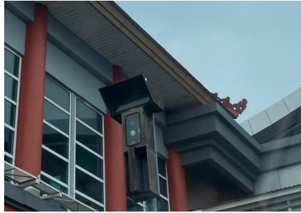
Gambar 2. 36 Advance Docking Guidance System (ADGS) Sumber : Dokumentasi Penulis
