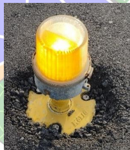
Gambar 2. 26 Lampu Runway Edge light tipe Elevated Sumber : Dokumentasi Penulis
