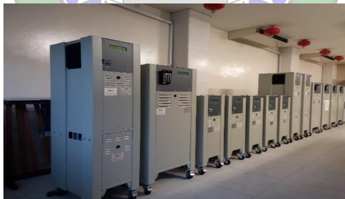
Gambar 3. 10 Constant current regulator Sumber: Dokumentasi Penulis
