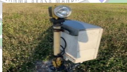
Gambar 2. 32 Lampu RTIL Sumber : Dokumentasi Penulis
