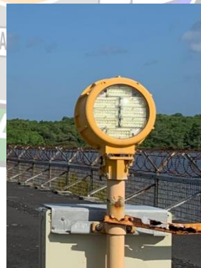
Gambar 2. 30 Lampu Sequence Flashing light (SQFL) Sumber : Dokumentasi Penulis
