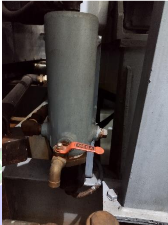
Gambar 3. 4 Radiator Sumber : Dokumentasi Pribadi 2023
