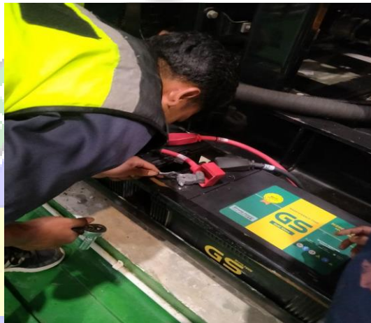
Penggantian Aki Pada Genset
