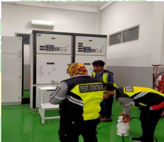
Pembersihan Sub Station Dari Hama
