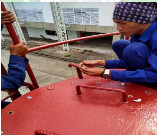
Pembersihan Karat Pada Mur Dan Baut Tangki Solar
