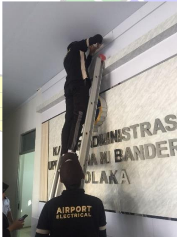
Pemasangan Lampu terminal
