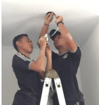
Pemasangan Lampu Terminal
