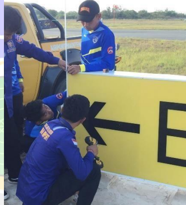
Pemasangan Lis TGS
