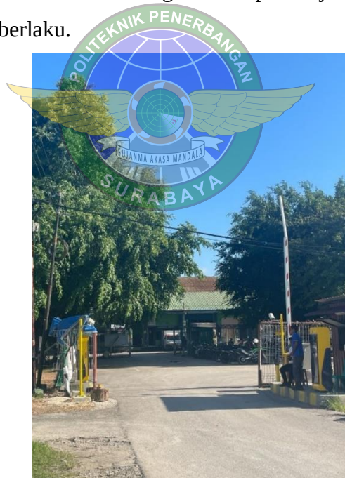
Gambar 4. 8 Toll Gate Masuk dan Keluar Area Kargo Bandar Udara Internasional El Tari Kupang
