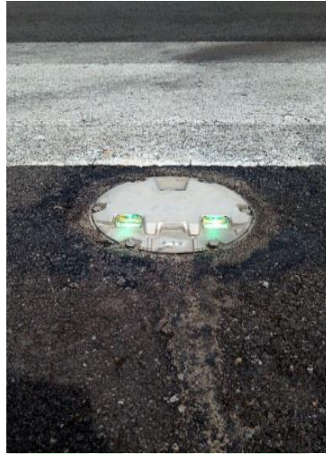
Gambar 2. 24 Insert Threshold Light Sumber : Dokumentasi Penulis
