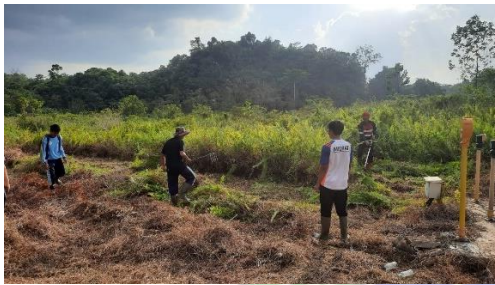
Membersihkan Area Approach
