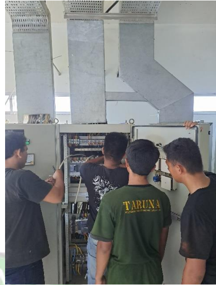
Memasang MCB untuk Outdoor AC
