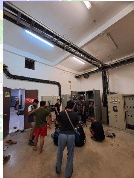
Memperbaiki Kerusakan Pada ACB Panel ACOS Genset 3
