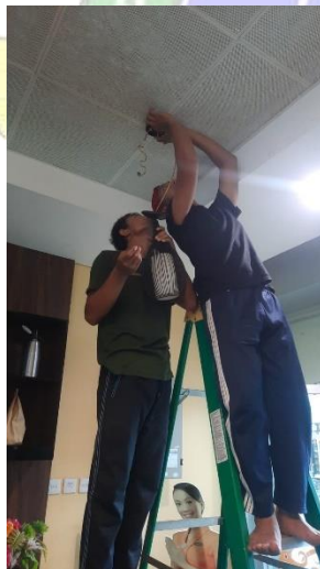
Memasang Lampu Gantung
