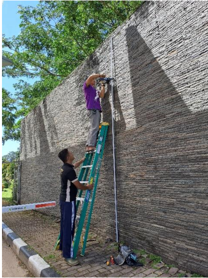
Menginstall lampu Sorot Pada Portal Parkir
