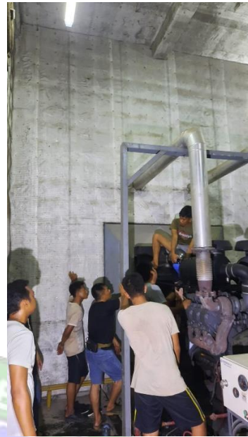
Pemeliharaan Genset (Mengganti Oli, Filter Oli, Filter Udara, Air Coolant, dan pembersihan Genset)
