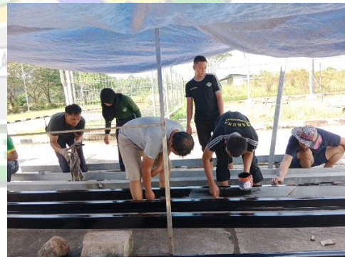
Mengecat Tiang Pondasi Solar Cell
