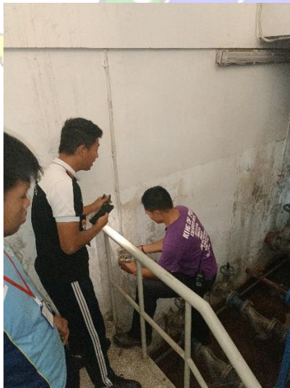
Memperbaiki Instalasi Lampu Pada Rumah Pompa
