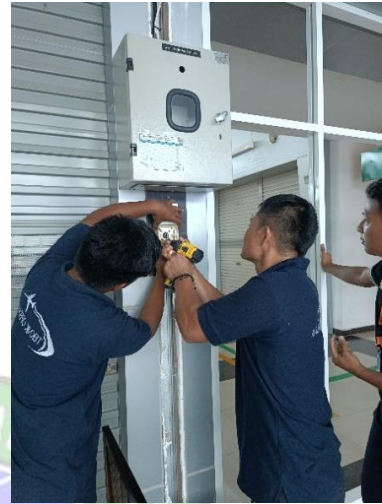
Menginstal Stopkontak
