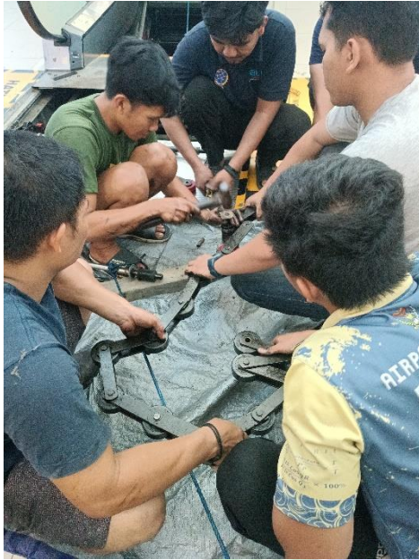
Mengganti Roller Rantai Eskalator
