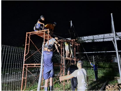
Kerja Bakti Membangun Solar Cell
