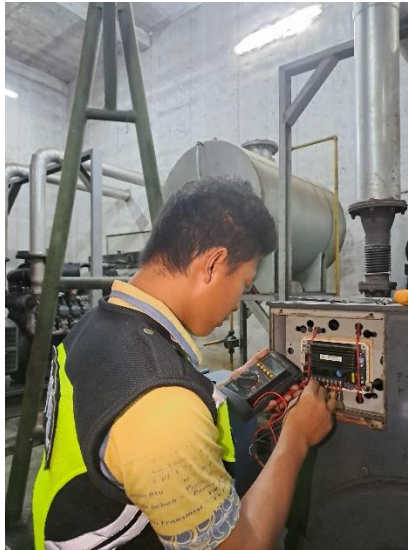
Gambar 4. 5 Memeriksa sambungan terminal pada AVR Sumber : Dokumentasi Penulis
