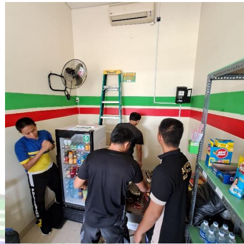
Memasang Instalasi power AC & KWH
