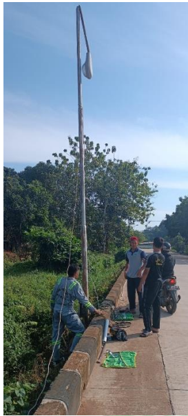
Memperbaiki Lampu Jalan
