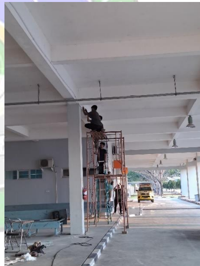
Pemasangan Kabel Outdoor AC
