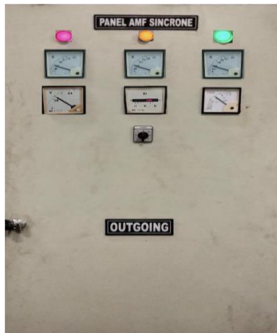
Gambar 4. 14 Panel AMF sincrone Sumber : Dokumentasi Penulis
