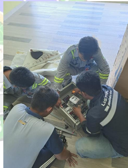
Memasang Instalasi KWH Meter
