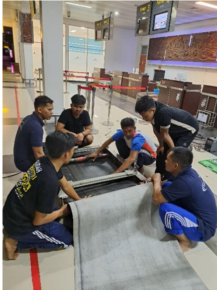
Mengganti Belt Conveyor Baru
