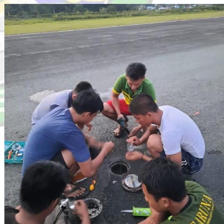
Mengganti Lampu Center Line
