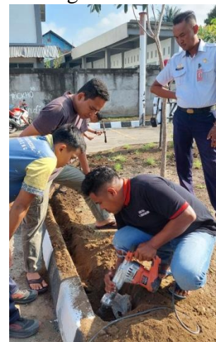
Pemasangan pipa untuk kabel ke tower pompa
