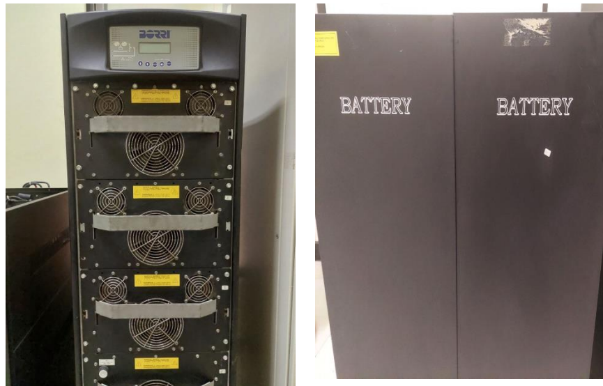
Gambar 4.2 UPS BORRI B8033FXS dan Baterai Sumber : Bandar Udara H. Hasan Aroeboesman
