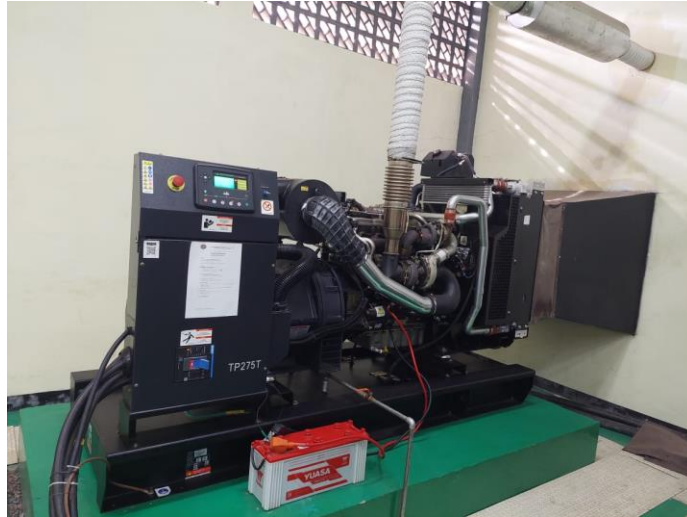
Gambar 2.4 Generator Set 250 kVA Sumber: Bandara H. Hasan Aroeboesman
