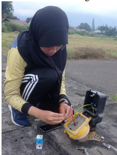
Penggantian halogen runway end light
