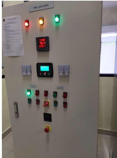
Gambar 2.7 Panel ACOS 250 kVA Sumber: Bandara H. Hasan Aroeboesman
