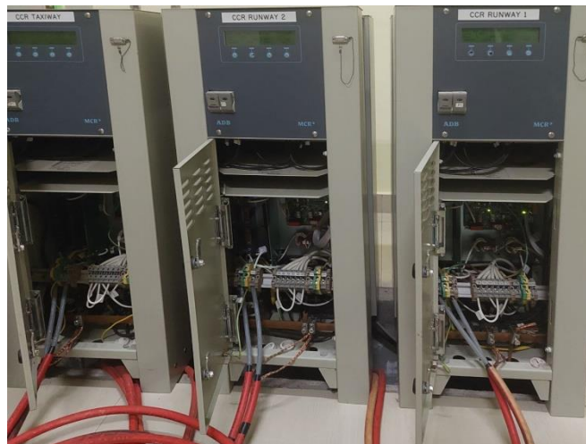
Gambar 2.11 CCR Taxiway dan CCR Runway Sumber: Bandara H. Hasan Aroeboesman
