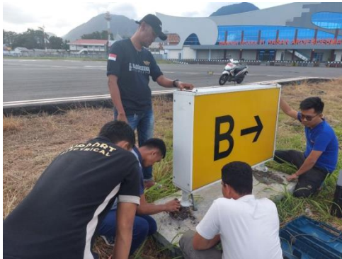
Perbaikan TGS Bravo
