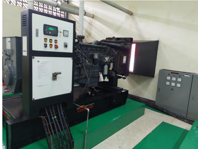
Gambar 2.3 Generator Set 150 kVA Sumber: Bandara H. Hasan Aroeboesman
