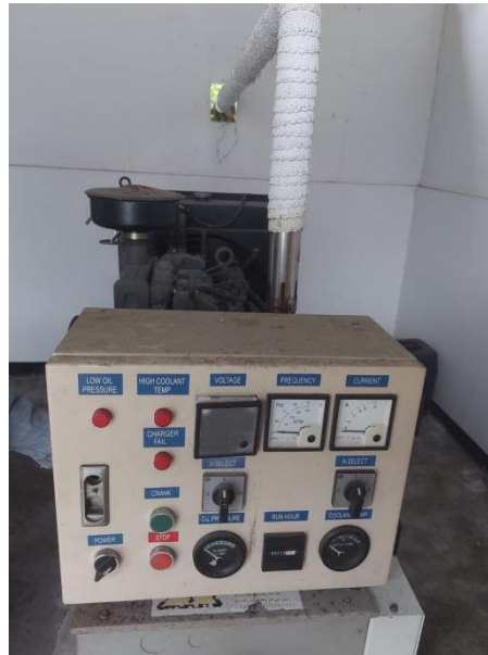
Gambar 2.5 Generator Set 25 kVA Sumber: Bandara H. Hasan Aroeboesman
