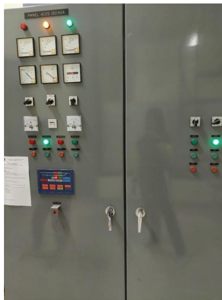
Gambar 2.6 Panel ACOS 150 kVA Sumber: Bandara H. Hasan Aroeboesman
