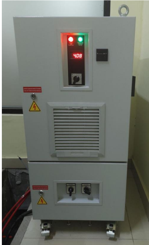
Gambar 2.12 CCR A-PAPI Sumber: Bandara H. Hasan Aroeboesman
