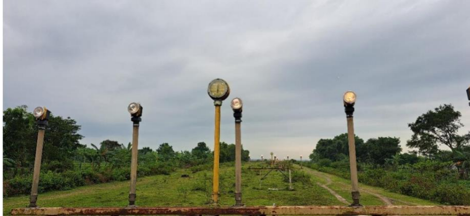
Gambar 2. 6 Approach Lighting PALS 13 Sumber : Dokumentasi penulis
