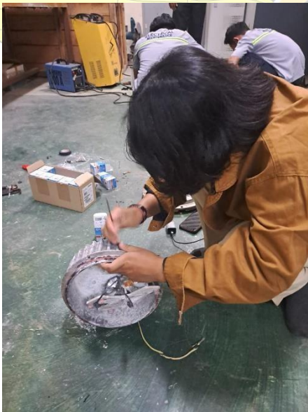
Gambar 5. 4 perakitan lampu inset
