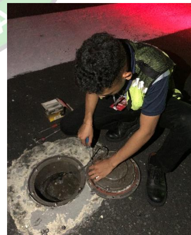
Perbaikan Lampu Threshold Inset
