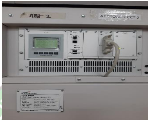
Gambar 2. 20 CCR ADB untuk Circuit Approach
