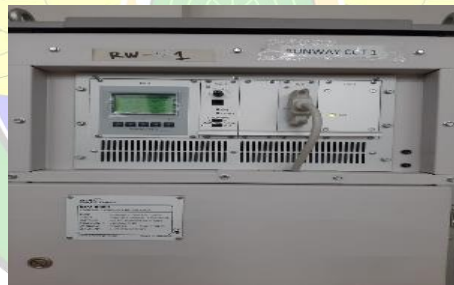
Gambar 2. 22 CCR untuk Circuit Runway
