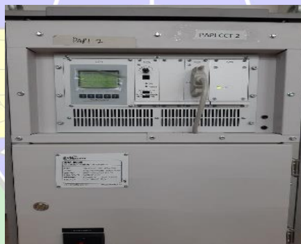
Gambar 2. 21 CCR untuk Circuit PAPI
