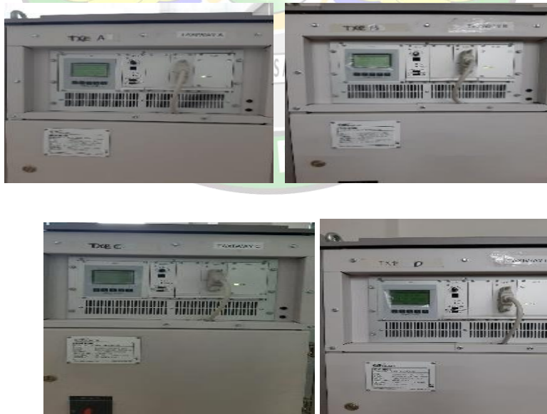
Gambar 2. 23 CCR untuk Circuit Runway A, B, C, D
