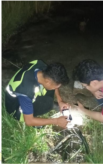
Perawatan Lampu Apron
