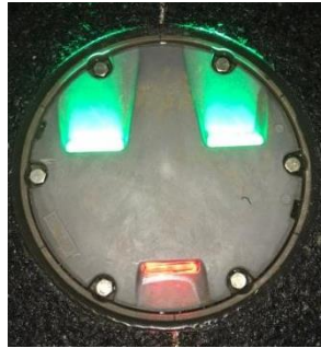
Gambar 2.8 Threshold Light dan Runway End Light tipe Insert & Elevated Sumber: Bandar Udara Internasional Syamsudin Noor
