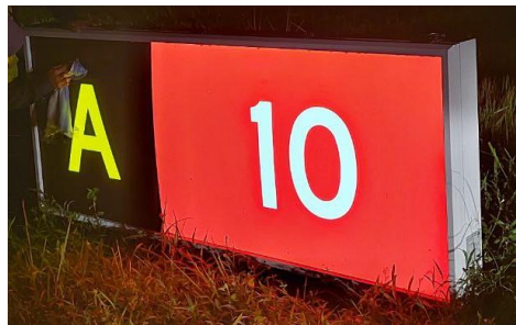
Gambar 2.13 Movement Area Guidance Sign tipe Mandatory Sumber: Bandar Udara Internasional Syamsudin Noor
