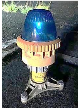
Gambar 2.19 Turning Area Light Sumber: Bandar Udara Internasional Syamsudin Noor
