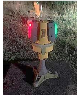
Gambar 2.8 Threshold Light dan Runway End Light tipe Insert & Elevated Sumber: Bandar Udara Internasional Syamsudin Noor
