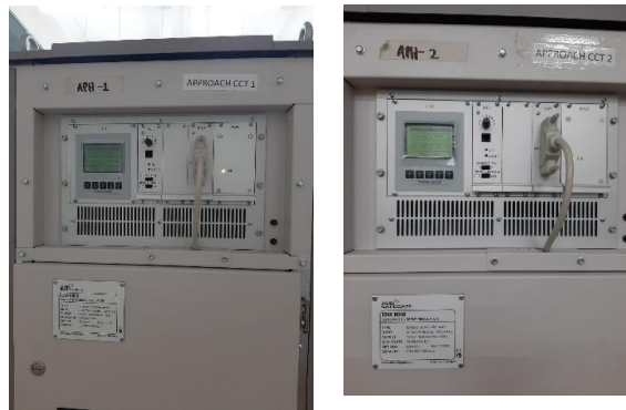
Gambar 2.21 CCR ADB untuk Circuit Approach Sumber : Bandar Udara Internasional Syamsudin Noor
