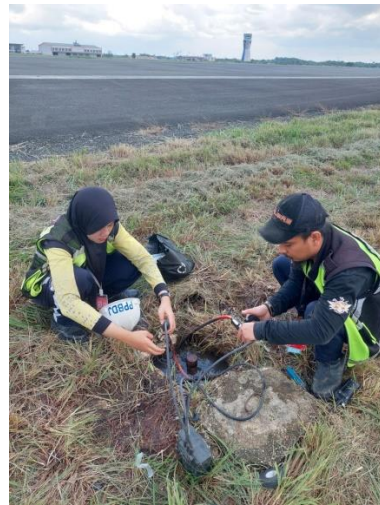
Perbaikan sambungan kabel primer dan sekunder trafo seri Runway Edge Light
