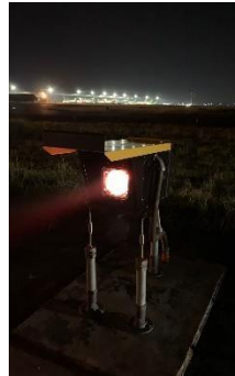
Gambar 2.10 Precision Approach Path Indicator Sumber: Bandar Udara Internasional Syamsudin Noor
