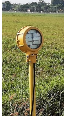
Gambar 2.6 Sequence Flashing Light Sumber: Bandar Udara Internasional Syamsudin Noor
