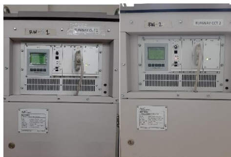
Gambar 2.23 CCR untuk Circuit Runway Sumber : Bandar Udara Internasional Syamsudin Noor
