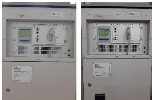
Gambar 2.22 CCR untuk Circuit PAPI Sumber : Bandar Udara Internasional Syamsudin Noor
