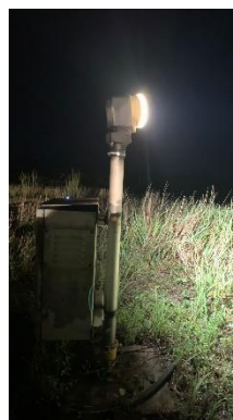
Gambar 2.7 Runway Threshold Identification Light Sumber: Bandar Udara Internasional Syamsudin Noor
