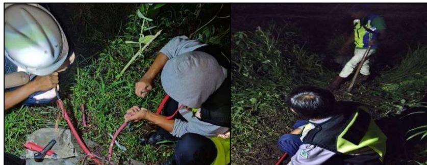
Gambar 4. 28 Penyuntikan Taxiway Bravo ke Taxiway SP/A
