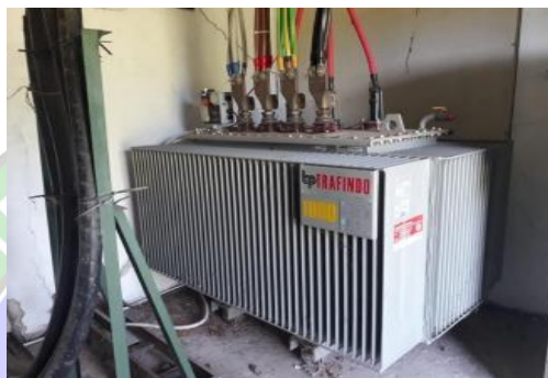
Gambar 4. 2 Trafo 1000 kVA
