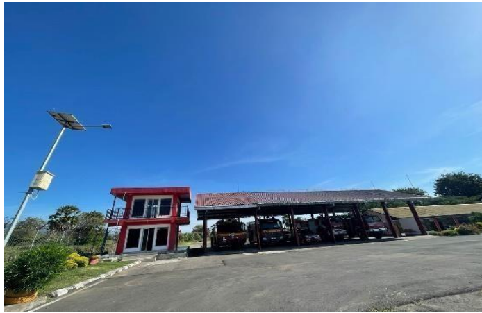
Gambar 2. 8 Gedung Fire Station Bandar Udara Fransiskus Xaverius Seda Maumere
