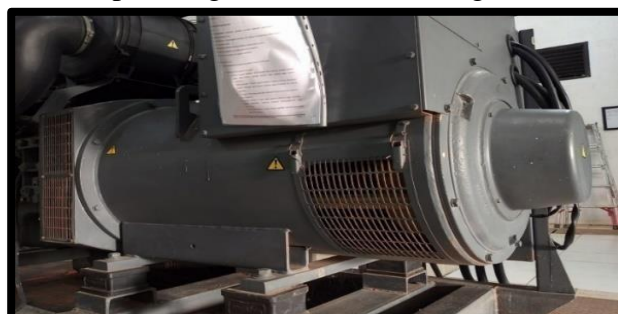
Gambar 3. 3 Alternator Sumber : Dokumentasi Pribadi
