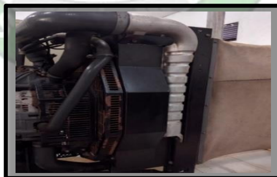
Gambar 3. 10 Radiator Sumber : Dokumentasi Pribadi
