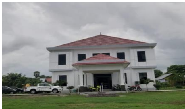
Gambar 2. 6 Gedung Administrasi Sumber : Dokumentasi Pribadi
