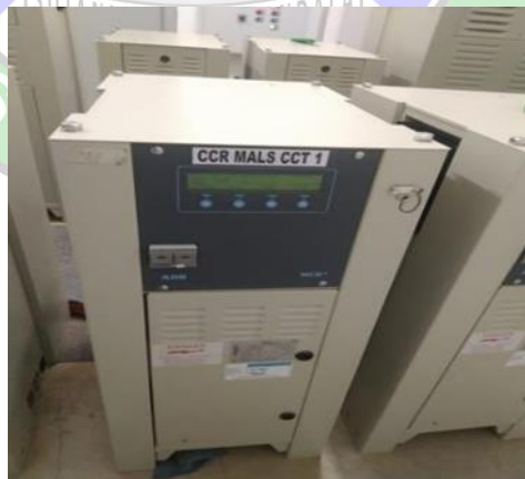
Gambar 2. 27 Constant Current Regulator Sumber: Dokumentasi penulis
