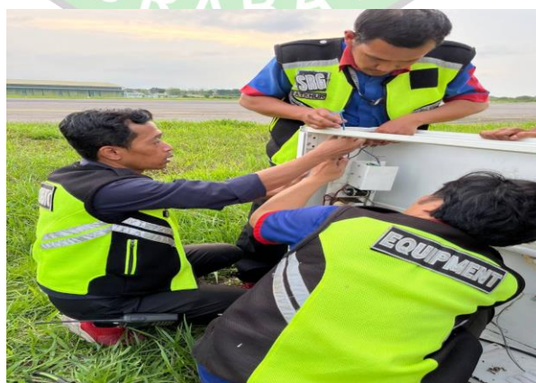
Gambar 4. 4 Pemasangan Taxiway Guidance Sign Foxtrot Sumber: Dokumentasi penulis
