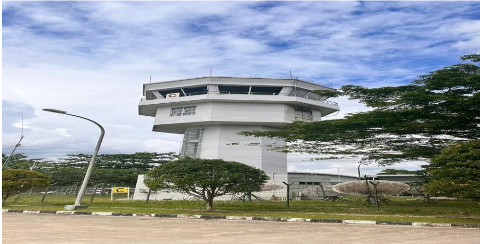
Gambar 2.14 Bangunan Menara ATC
