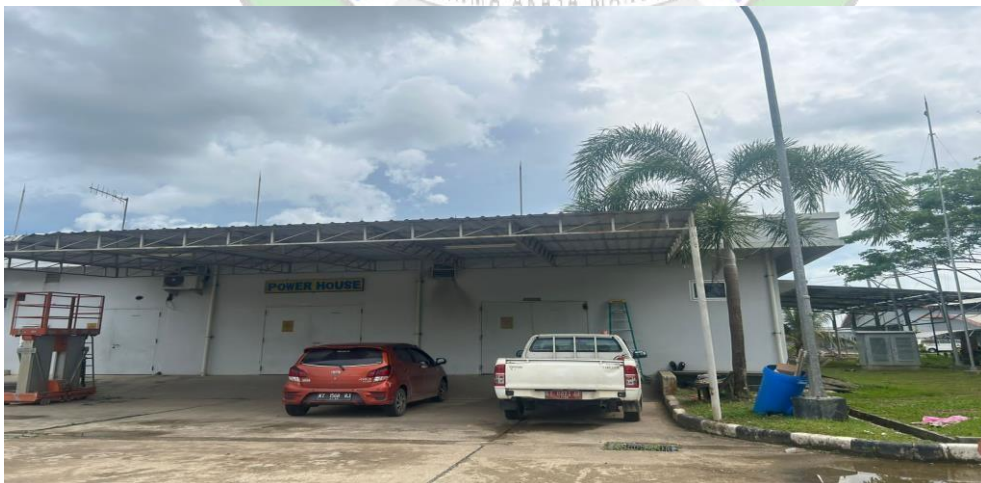
Gambar 2.13 Bangunan Power House
