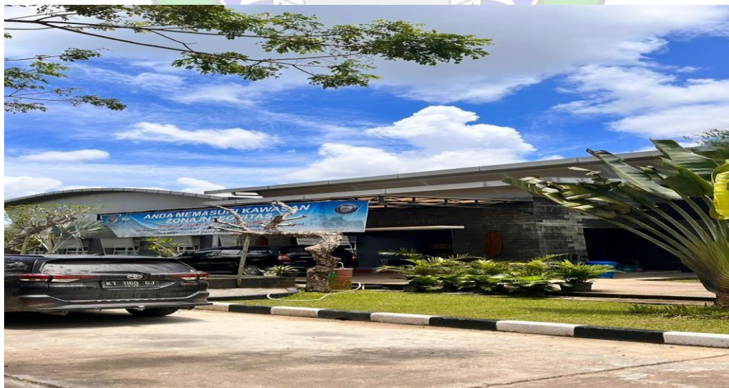
Gambar 2.11 Bangunan Operasional/ Kantor
