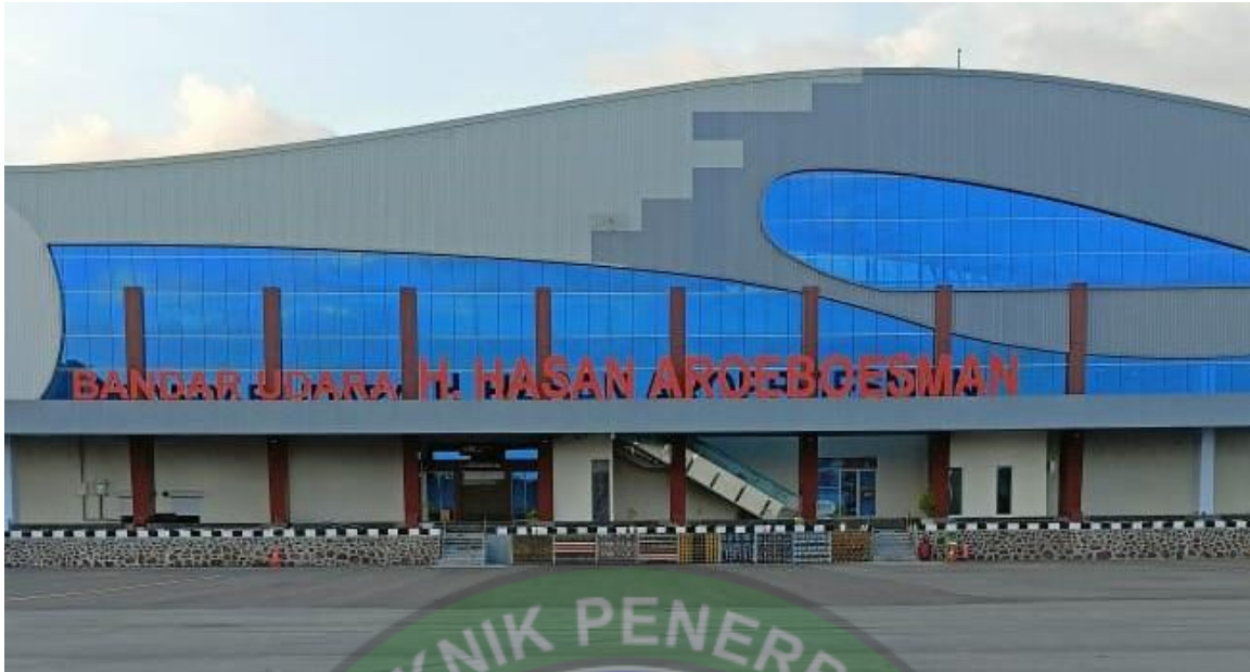
Gambar 2. 1 Terminal baru Bandar udara H.Hasan Aroeboesman Ende
