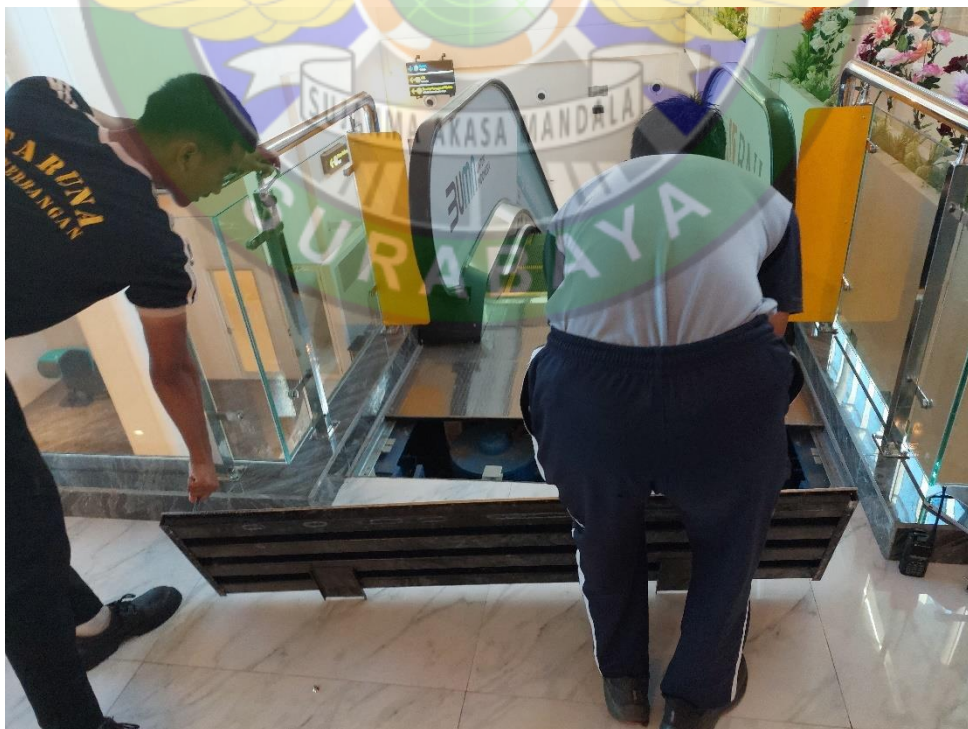
Perbaikan lampu mandatory guide sign
