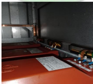
Gambar 4. 8 Pemasangan Kabel sekunder CT
