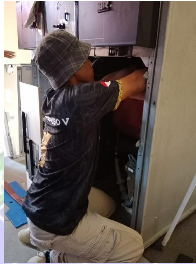
Gambar 4. 7 Pemasangan Busbar dari CT ke Kabel Outgoing
