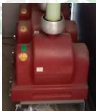
Gambar 3. 7 Trafo Tegangan
