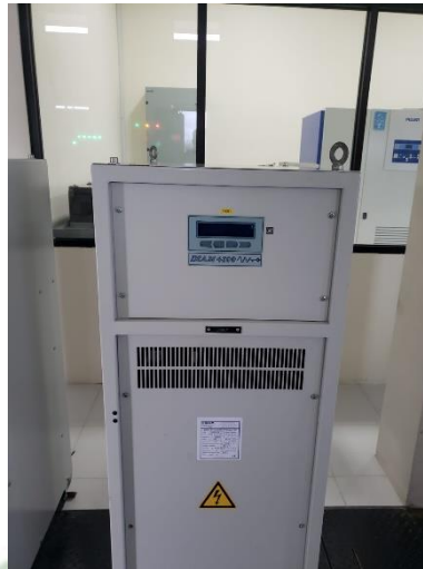
Gambar 2. 29 CCR Augier Type DIAM 4100 Sumber : Bandara Internasional Juwata Tarakan
