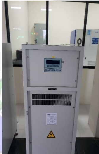
Gambar 2. 28 CCR Augier Type DIAM 4000 Sumber : Bandara Internasional Juwata Tarakan
