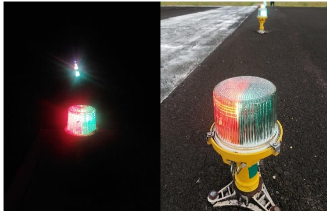
Gambar 2. 19 Threshold Light dan Runway End Light Sumber : Bandara Internasional Juwata Tarakan
