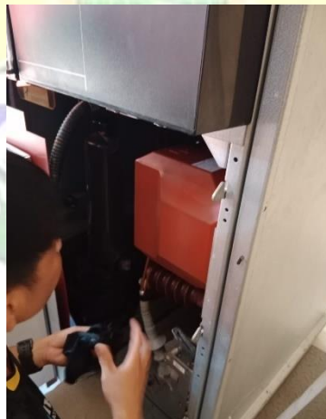
Gambar 4. 6 Pemasangan Busbar Dari CT ke Fuse
