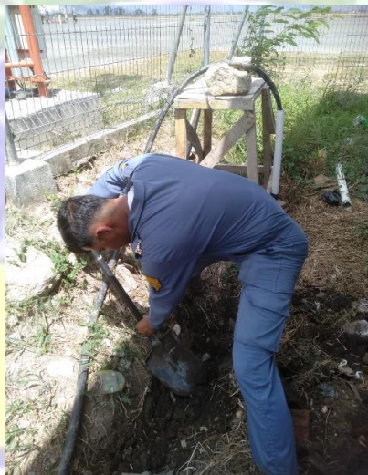
Gambar 4.10 Penggalan jalur kabel sedalam 0,6 m
