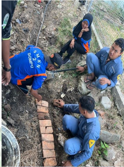
Gambar 4.11 Penanaman kabel dengan pasir dan batu bata
