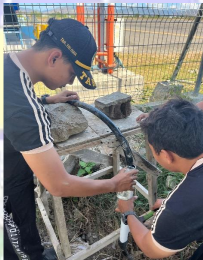
Gambar 4.9 Menuangkan cairan resin pada pipa
