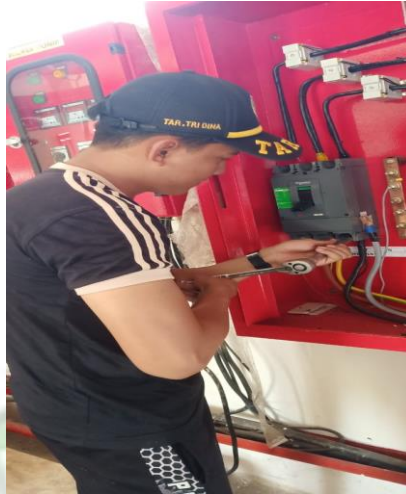
Gambar 4.8 Melepas sambungan kabel yang terhubung pada MCCB
