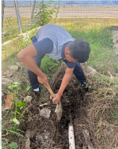
Gambar 4.4 Penggalian tanah sebelum penyambungan kabel
