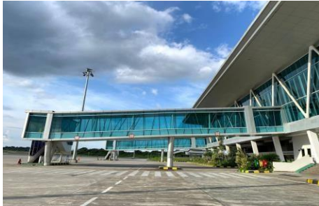
Gambar 2. 5 Fixed Bridge Sumber : UPBU A.P.T. Pranoto Samarinda
