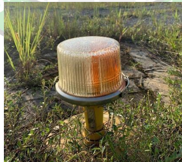
Gambar 2. 23 Kontruksi R/W edge Light Sumber : UPBU A.P.T. Pranoto Samarinda
