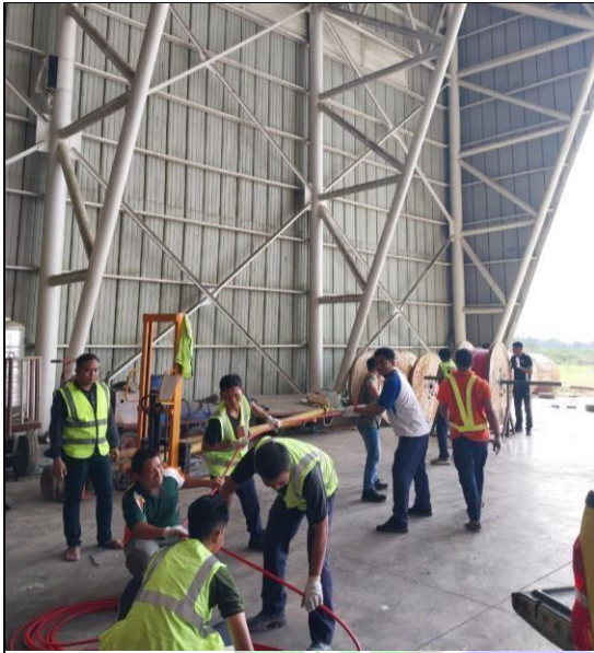
Penarikan Kabel AFL
