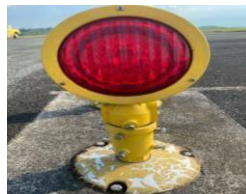
Gambar 2. 25 Runway End Light Sumber : UPBU A.P.T. Pranoto Samarinda
