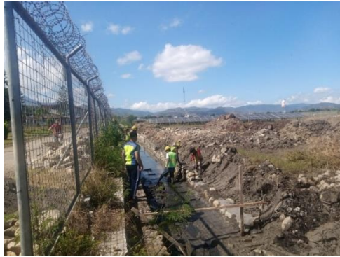
Gambar 4.15 Proses pemasangan batu kali
