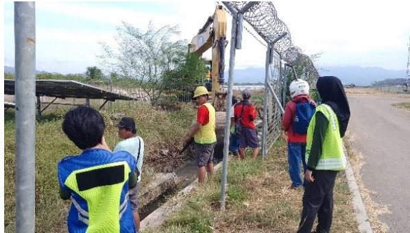
Gambar 4.11 Perombakan dan Pembersihan
