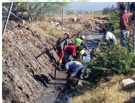
Gambar 4.13 Pembersihan di lokasi drainase
