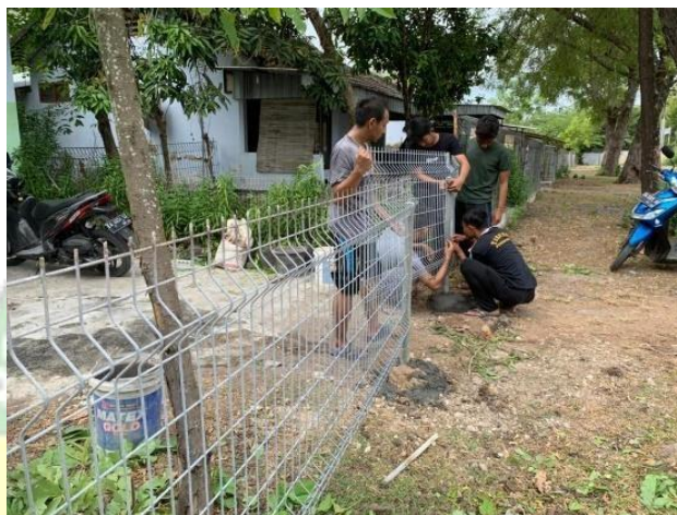
Gambar 4.17 Pemasangan pagar rumah dinas
