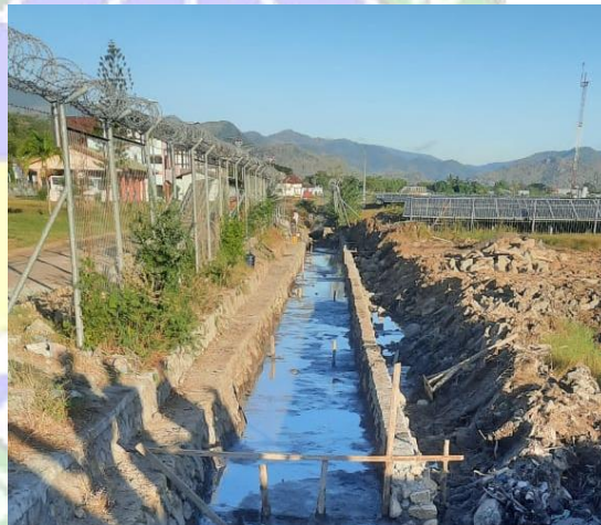
Gambar 4.14 Penghamparan lantai kerja
