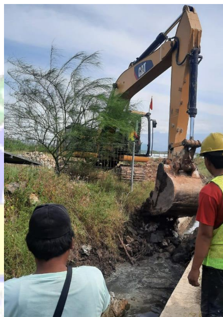
Gambar 4.12 Perombakan dan pembersihan dengan alat excavator
