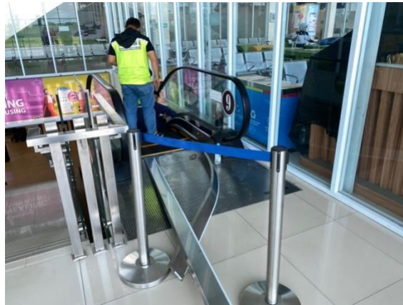
Gambar 4.2 Escalator menuju Arrival lantai 1
