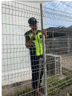
Gambar 4.16 Pemasangan baut pada tiang pagar
