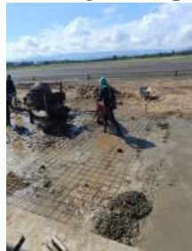
(Gambar 4.16 Penuangan campuran)
