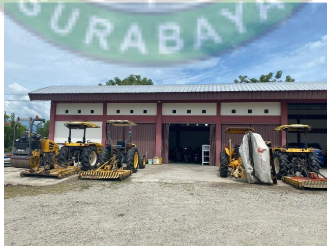
Gambar 4. 2 Gedung Bangunan dan Landasan
