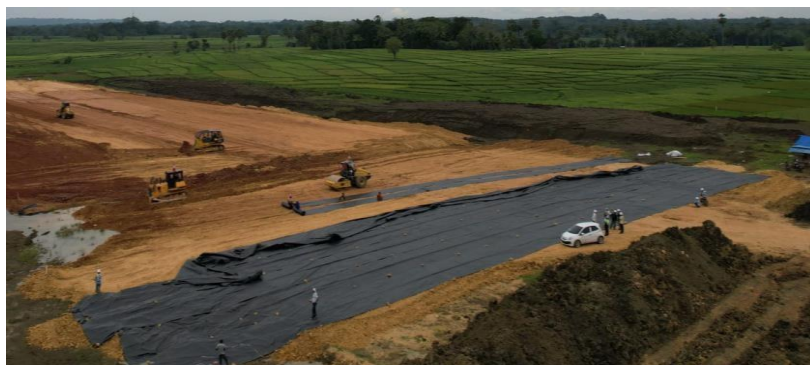
Gambar 4.22. Pemasangan geotekstil
