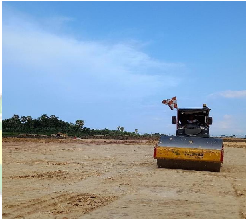
Gambar 4.25. Pemadatan tanah
