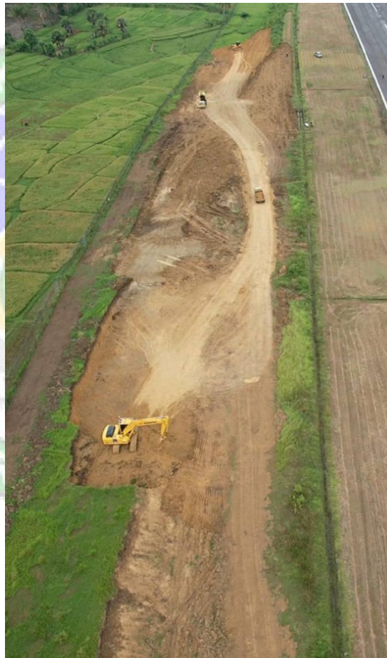
Gambar 4.24. Penimbunan tanah
