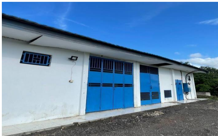
Gambar 4.4. Gedung Power House
