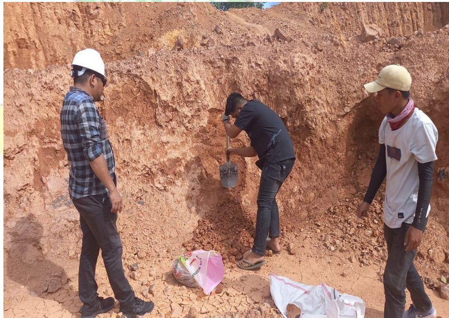
Gambar 4.20. Cek material tanah timbunan
