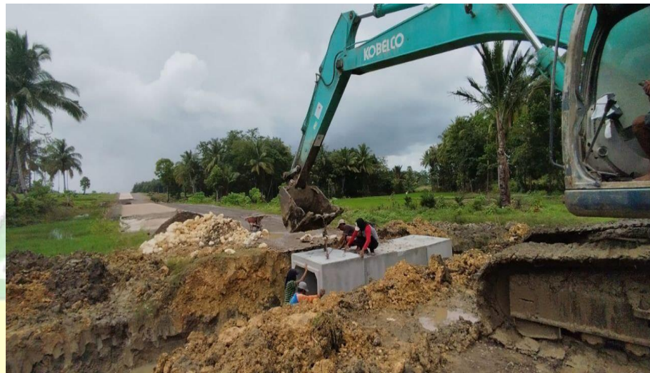
Gambar 4.19. Pemasangan Box Culvert
