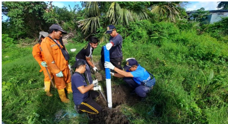
Gambar 4. 18 Memasukkan Adukan Semen Ke Lubang
