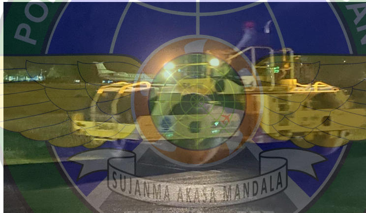
Gambar 4.33 Pemadatan Dengan Tandem Roller
