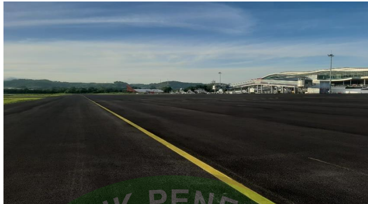
Gambar 4. 17 kondisi setelah overlay
