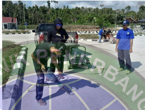
Gambar 4. 27 Pembongkaran Perkerasan (Sumber: Olahan Penulis, Tahun 2023)
