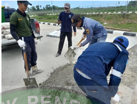
Gambar 4. 29 Pembuatan Adonan Beton (Sumber: Olahan Penulis, Tahun 2023)
