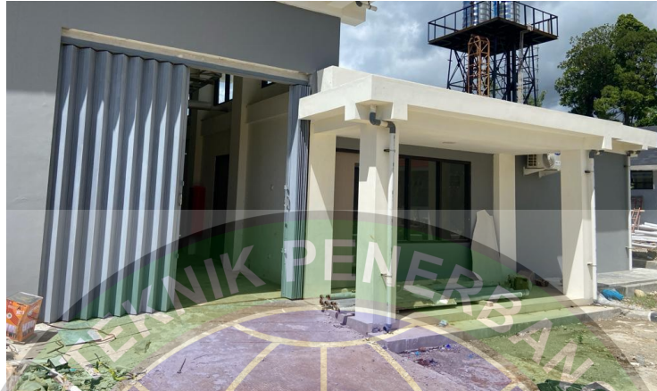
Gambar 4. 6 Gedung Power House Mentawai (Sumber: Olahan Penulis, Tahun 2023)
