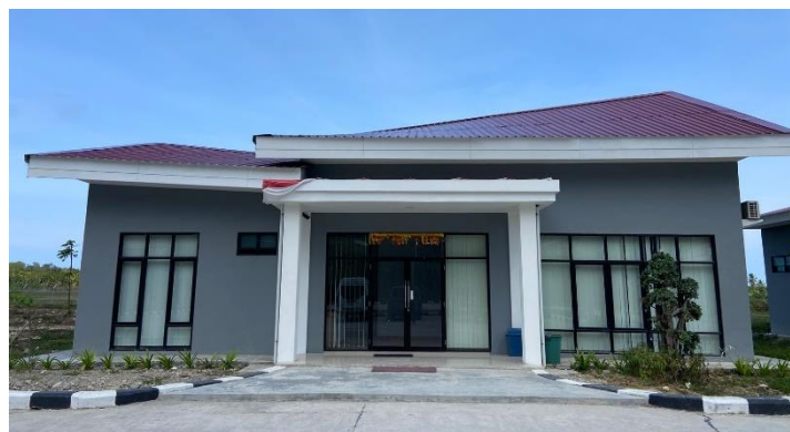
Gambar 4. 9 Gedung Operasional Bandara Mentawai (Sumber: Olahan Penulis,2023)
