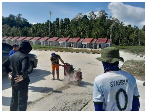
Gambar 4. 26 Memotong plotting area (Sumber: Olahan Penulis, Tahun 2023)
