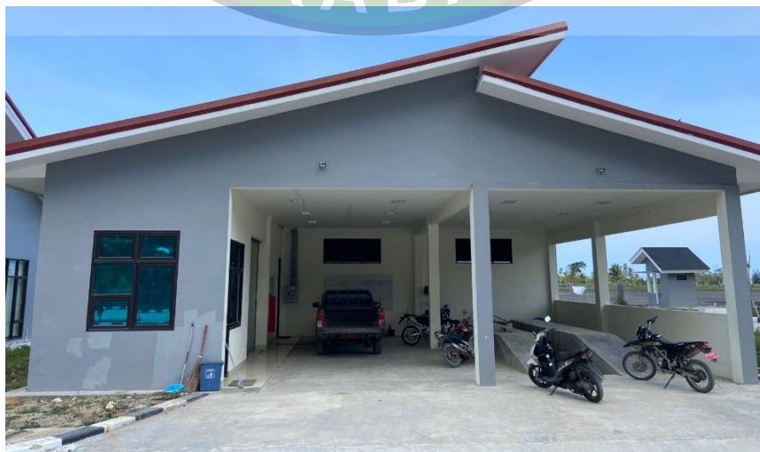
Gambar 4. 11 Gedung Bengkel Bandara Mentawai (Sumber: Olahan Penulis,2023)
