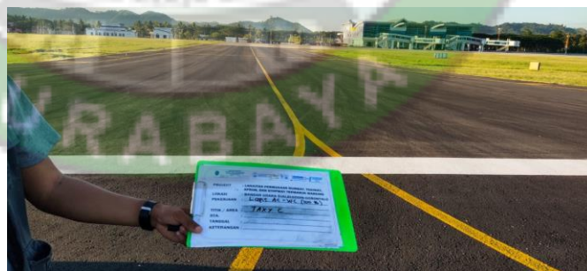
Gambar 4. 50 Kondisi Taxiway Charlie setelah Overlay (Sumber: Dokumentasi Penulis, Tahun 2023)
