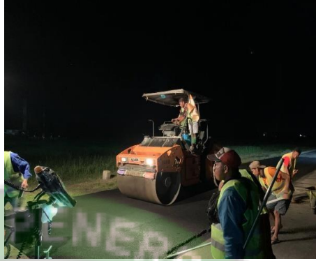
Gambar 4. 45 Proses Pemadatan Pertama (Sumber: Dokumentasi Penulis, Tahun 2023)
