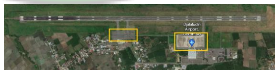
Gambar 4. 3 Satelite View Apron Bandar udara Djalaluddin Gorontalo (Sumber: Google Maps , Tahun 2023)
