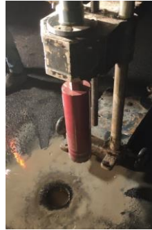
Gambar 4. 48 Core Drill (Sumber: Dokumentasi Penulis, Tahun 2023)
