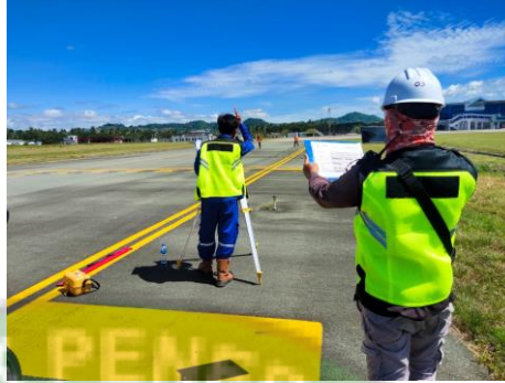
Gambar 4. 15 Survei Taxiway Charlie (Sumber: Dokumentasi Penulis, Tahun 2023)
