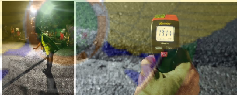
Gambar 4. 44 Pengukuran Suhu Hampar (Sumber: Dokumentasi Penulis, Tahun 2023)
