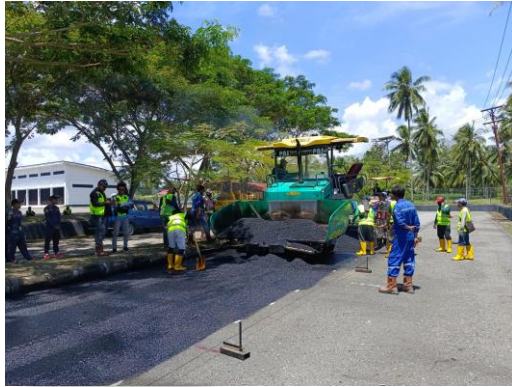
Gambar 4. 40 Trial Compaction (Sumber: Dokumentasi Penulis, Tahun 2023)
