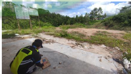
Gambar 4. 19 Penentuan Titik Koordinat As Bangunan Rencana (Sumber: Dokumentasi Penulis, Tahun 2024)
