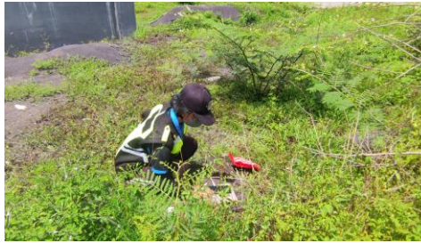
Gambar 4. 20 Penentuan Titik Koordinat As Bangunan Rencana (Sumber: Dokumentasi Penulis, Tahun 2024)
