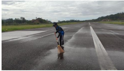
Gambar 4. 42 Pembersihan Area Water Ponding (Sumber: Dokumentasi Penulis, Tahun 2024)
