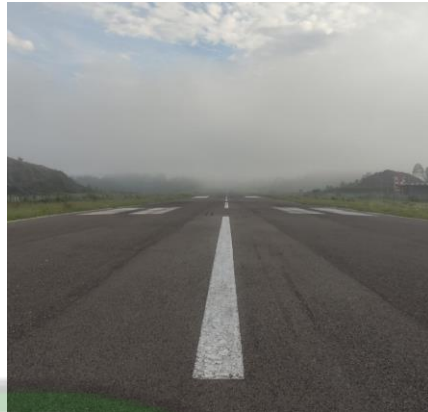
Gambar 4. 1 Runway Bandar Udara Toraja (Sumber: Dokumentasi Pribadi, Tahun 2024)
