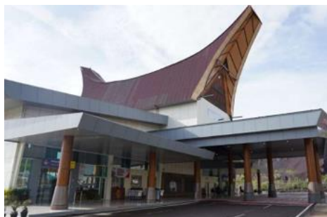
Gambar 4. 4 Terminal Penumpang Bandar Udara Toraja (Sumber: Dokumentasi Pribadi, Tahun 2024)
