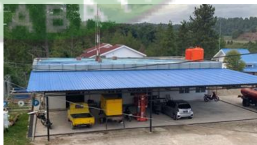
Gambar 4. 8 Gedung Power House (Sumber: Dokumentasi Pribadi, Tahun 2024)
