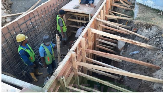
Gambar 4.20 Pemasangan Bekisting di Dalam Box
