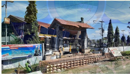
Gambar 4.16 Pemasangan Besi Tulangan
