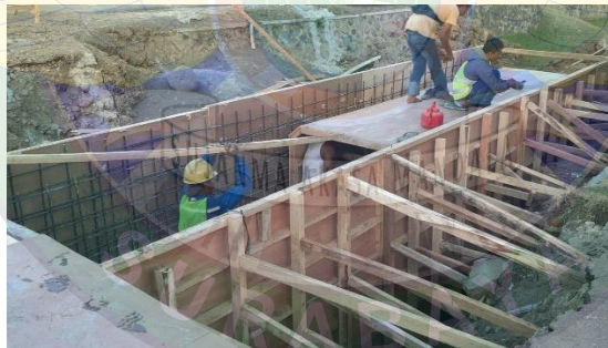
Gambar 4.19 Pemasangan Bekisting
