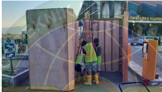
Gambar 4.18 Pembuatan Bekisting
