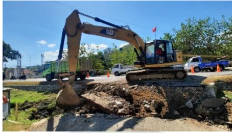
Gambar 4.15 Pembongkaran Aspal dan Sedimen
