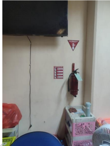
Lampiran 1 Posisi APAR yang tidak strategis
