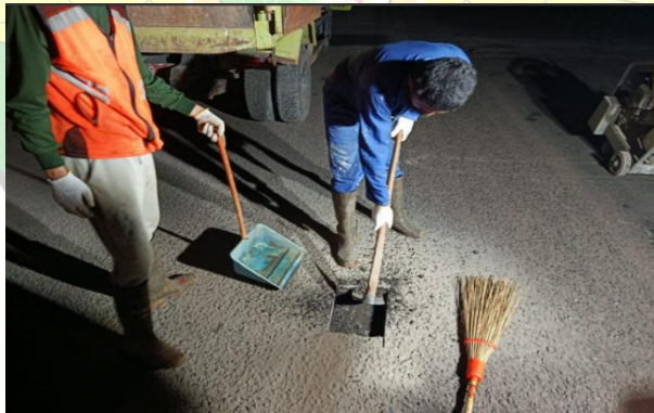
Gambar 4 13 (Pembersihan Setelah Pembongkaran)
