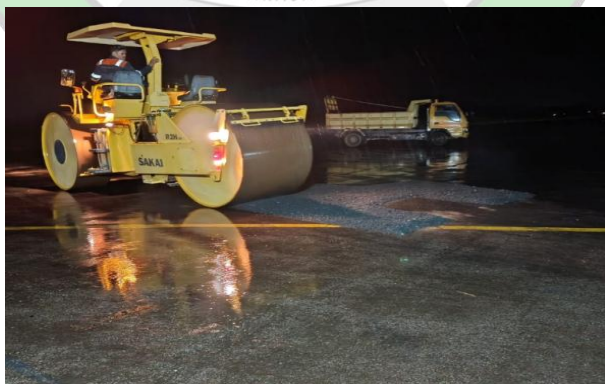
Gambar 4 17 (Pemadatan Menggunakan Tandem Roller)
