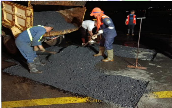
Gambar 4 15 (Pengangkutan Material Hot Mix)
