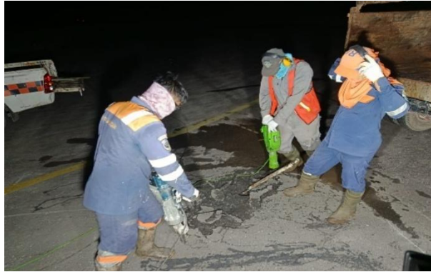
Gambar 4 12 (Pembongkaran Lapisan Aspal)
