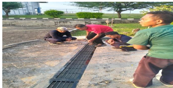
Gambar 4. 18 Pemasangan Besi Ulir Penutup Saluran Air
