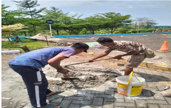
Gambar 4. 16 Pencampuran Bahan Semen dan Pasir
