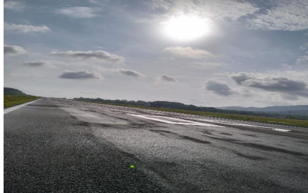
Gambar 4. 2 Runway Bandar Udara Harun Thohir Gresik
