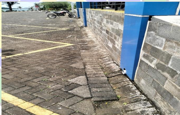
Gambar 4. 13 Pengecekan Area Sebelum Pembuatan Saluran
