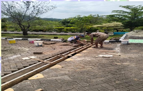
Gambar 4. 15 Pemasangan Kayu Sebelum Pengecoran
