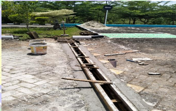
Gambar 4. 17 Tepi Saluran yang Telah dicor
