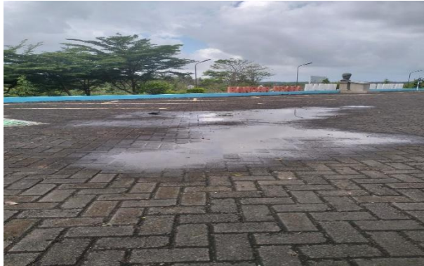
Gambar 4. 5 Air yang menggenang sebelum pembuatan drainase
