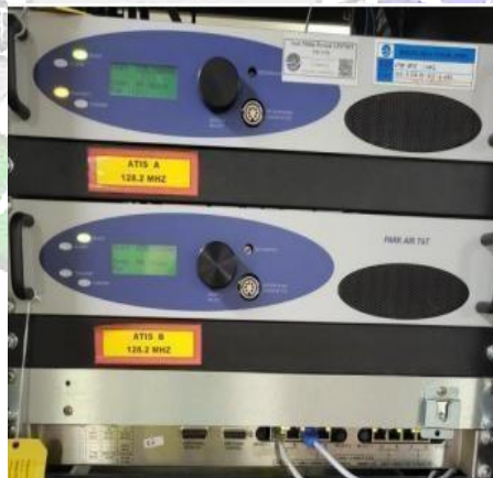
Gambar 3. 6 Server Transmitter Sumber: Dokumentasi Penulis
