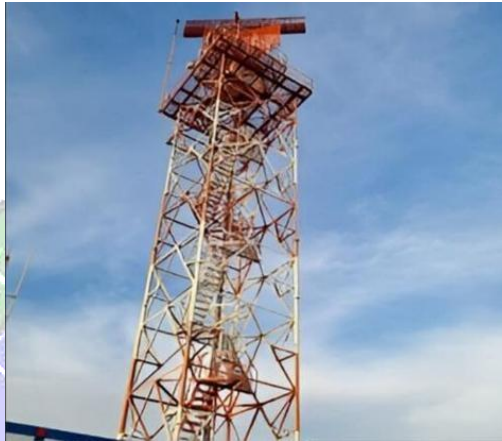
Gambar 3. 13 Radar MSSR Mode S Merk Eldis Sumber: Dokumentasi Penulis 2025
