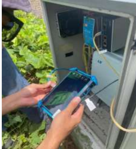
Gambar 3.18 pengujian kabel UTP CCTV menggunakan Lan tester
