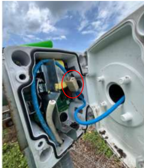
Gambar 3.21 Pemasangan Barrel Connector
