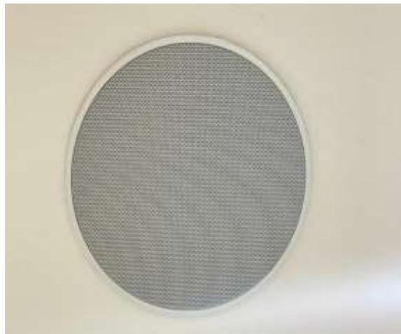
Gambar 3. 9 Ceiling speaker PAS 1
