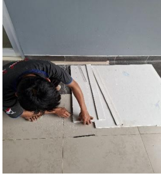
Gambar 4. 39 Pengukuran Kalsiboard
