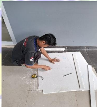
Gambar 4. 40 Pemotongan Kalsiboard
