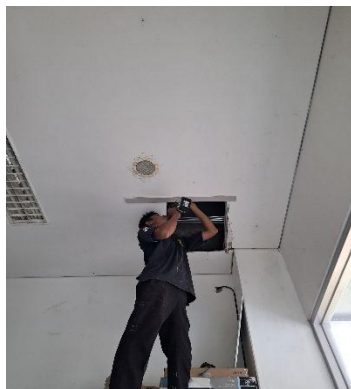
Gambar 4. 41 Pemasangan Kalsiboard
