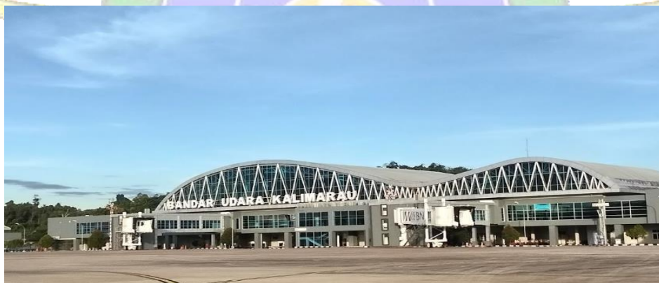
Gambar 2. 1 Bandar Udara Kalimantan Sumber : Dokumentasi Pribadi, Tahun 2025
