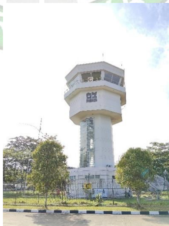
Gambar 4. 10 Gedung ATC Bandar Udara Kalimantan Berau
