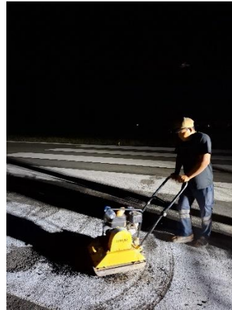
Gambar 4. 16 Pemadatan Menggunakan Stamper
