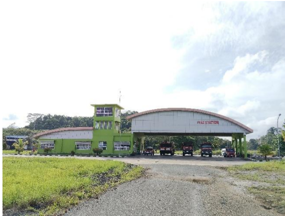
Gambar 4. 7 Gedung PKP-PK Bandar Udara Kalimantan Berau
