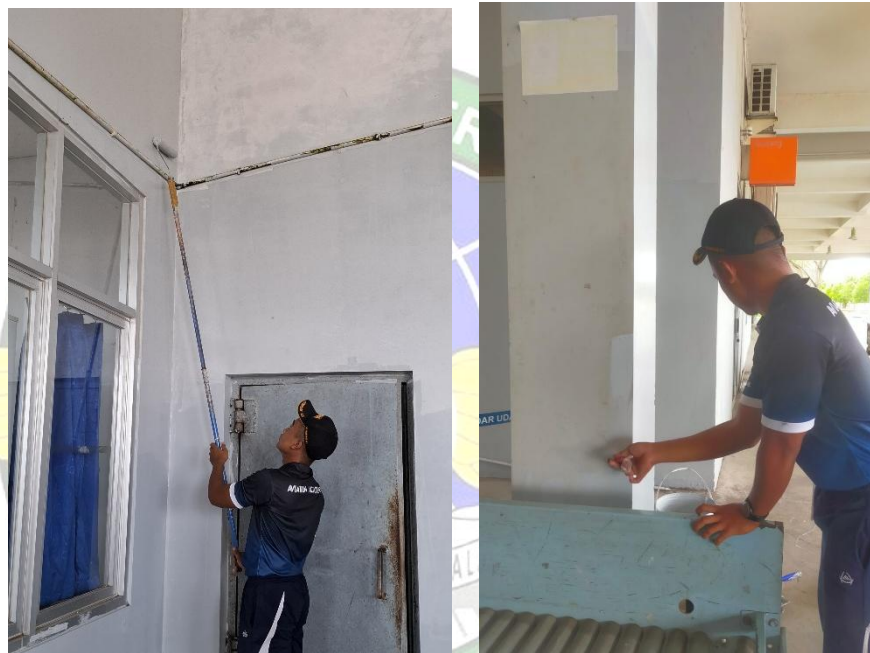
Gambar 4. 18 Pengecatan Ruangan Flop
