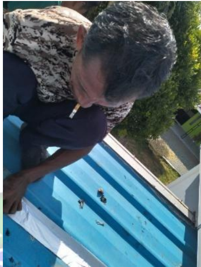
Gambar 4. 17 Penambahan Selotip Rekat Pada Atap Terminal
