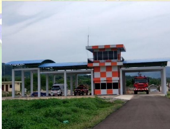
Gambar 4. 5 Gedung PKP-PK Bandar Udara Harun Thohir
