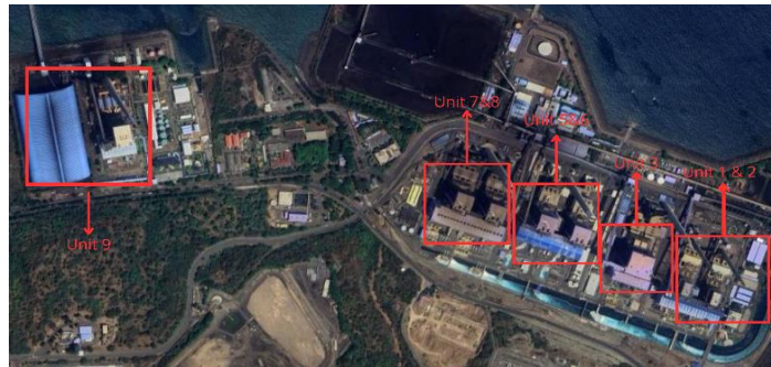
Gambar 2. 1 Pltu Paiton Unit 1-9
