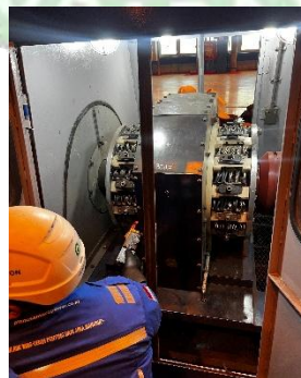
Gambar 4. 11 Pengukuran Tekanan Pegas
