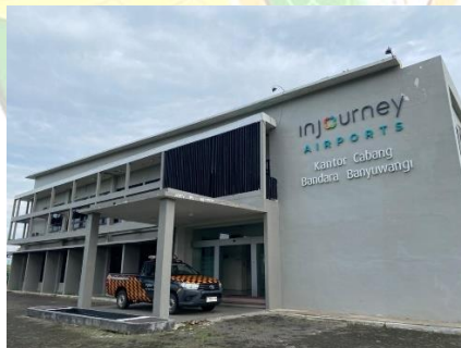
Gambar 4. 11 Kantor Administrasi Sumber: Dokumentasi Pribadi, 2025
