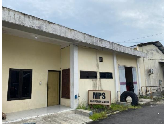
Gambar 4. 12 Power House Sumber: Dokumentasi Pribadi, 2025
