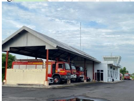
Gambar 4. 13 Gedung PKP-PK Sumber: Dokumentasi Pribadi, 2025
