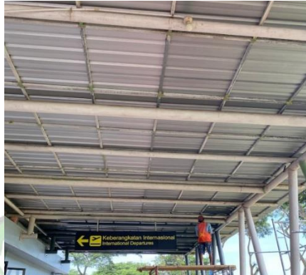
Gambar 4. 23 Proses Pengecatan Sumber: Dokumentasi Pribadi, 2025
