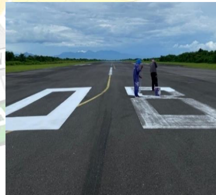
Gambar 4. 18 Pengecatan Designator Sumber: Dokumentasi Pribadi, 2025
