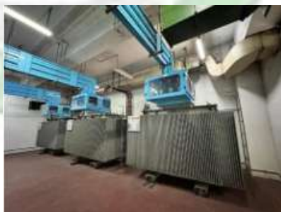
Gambar 2. 13 Trafo Terminal 2
