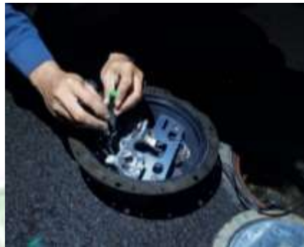
Gambar 4. 5 Analisa Kerusakan Pada Lampu
