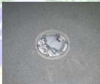
Gambar 4. 1 Observasi Perbaikan Runway Edge Light
