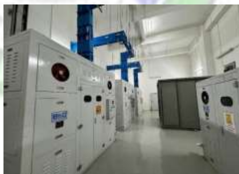
Gambar 2. 17 Trafo Genset RTT
