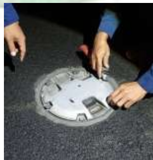
Gambar 4. 2 Proses Membuka Lampu Runway Edge Inset
