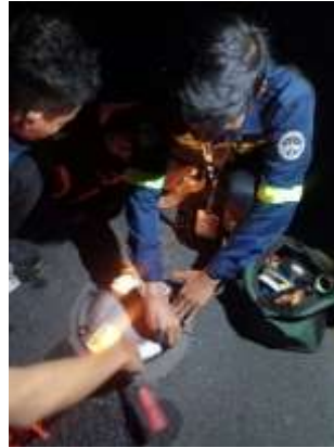
Gambar 4. 9 Selesai Perbaikan Pada Lampu Runway Edge Inset
