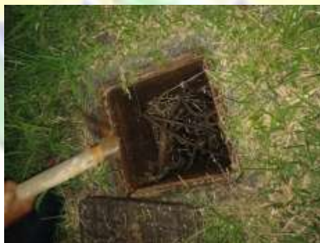
Gambar 4. 11 Pengecekan Bak kontrol Runway Edge Light
