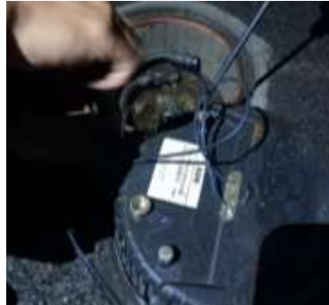
Gambar 4. 7 Pemasangan Kembali Konektor Lampu Runway Edge inset
