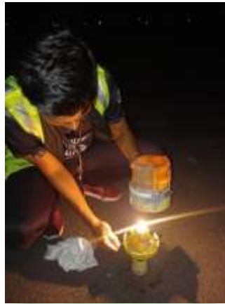
Gambar 4. 10 Mengganti glass cover pada lampu runway edge
