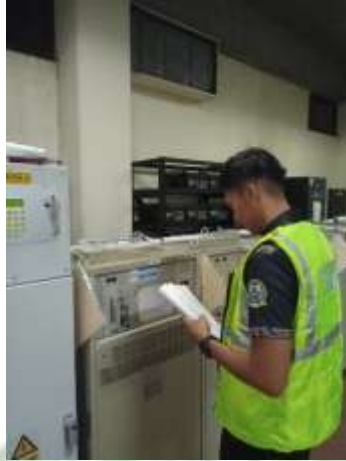
Gambar 4. 12 Memeriksa CCR pada Runway Edge Light
