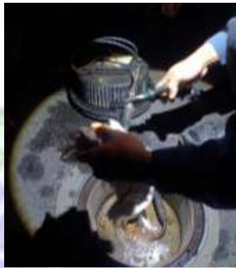
Gambar 4. 3 Proses Membuka Konektor Lampu Runway Edge Inset
