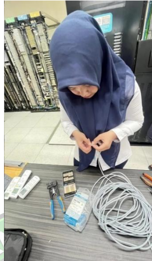
Gambar 3.11 4 Melakukan Crimping Kabel Konektor RJ45 Sumber: Dokumentasi Penulis 2025
