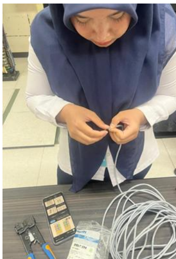
Gambar 3.11 3 Memotong & Mengupas kabel UTP Sumber: Dokumentasi Penulis 2025
