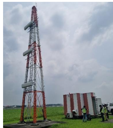
Gambar 3.3 Shelter & Antenna Glide Path Sumber : Dokumentasi Penulis 2025
