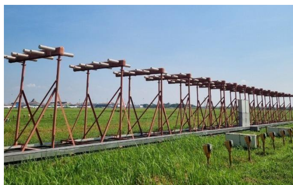
Gambar 3.3 4Shelter & Antenna Localizer Sumber : Dokumentasi Penulis 2025
