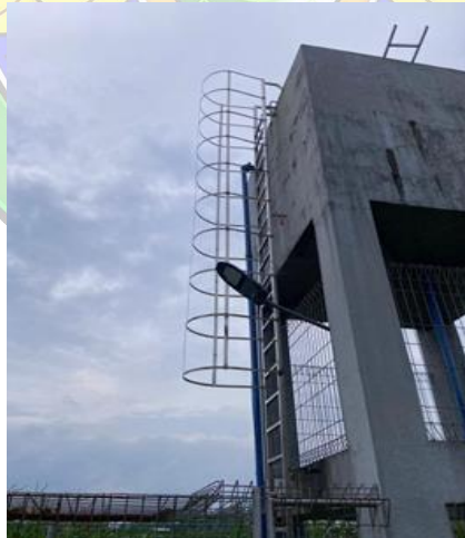
Gambar 3.4.9 1 Tangki Penampungan (Tandon) Sumber : Dokumentasi Penulis
