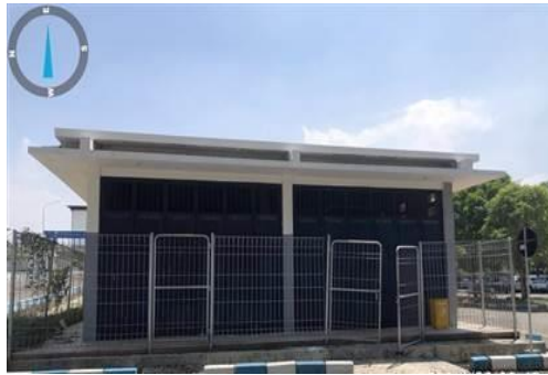
Gambar 3.1.3 11 Bangunan Power House Sumber : Dokumentasi Penulis 2026
