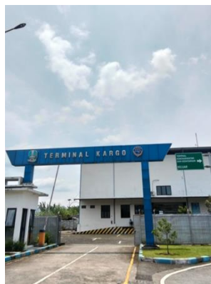
Gambar 3.1.3 9 Bangunan Terminal Kargo Sumber : Dokumentasi Penulis 2026
