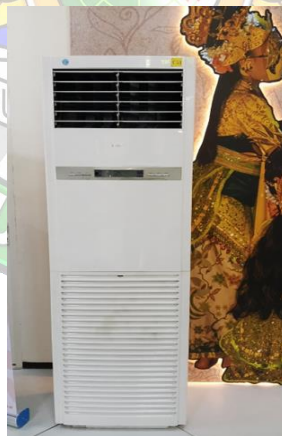
Gambar 3.1.4 1 AC Standing Floor Sumber : Dokumentasi Penulis 2026
