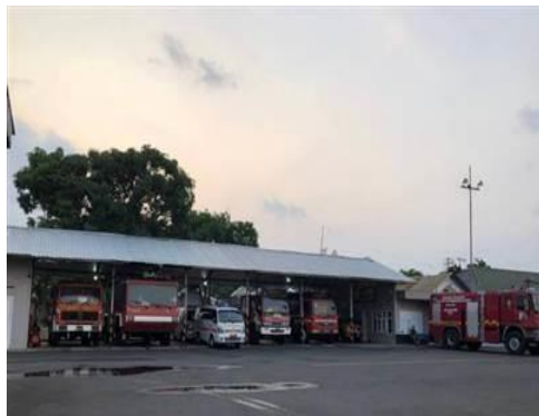
Gambar 3.1.3 14 Bangunan PKP-PK Sumber : Dokumentasi Penulis 2026
