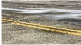
Apron Edge Line
