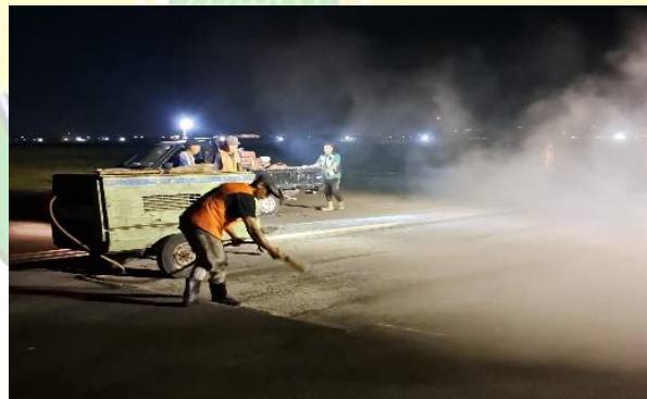
Gambar 4. 17 Pembersihan Menggunakan Mesin Sprayer (Sumber: Dokumentasi Penulis)
