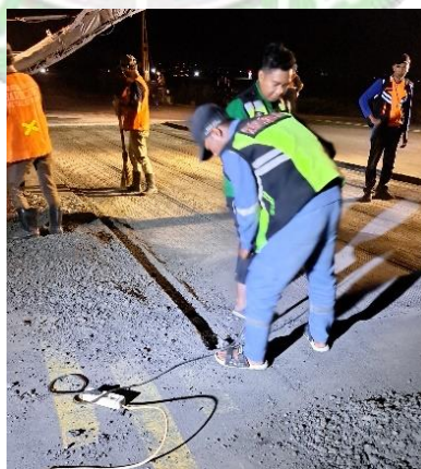
Gambar 4. 15 Pemotongan Aspal Menggunakan Jack Hammer (Sumber: Dokumentasi Penulis)
