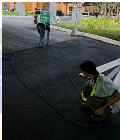
Gambar 4. 23 Mengukur Marka Jalan Sebelum Dilakukan Pengecatan
