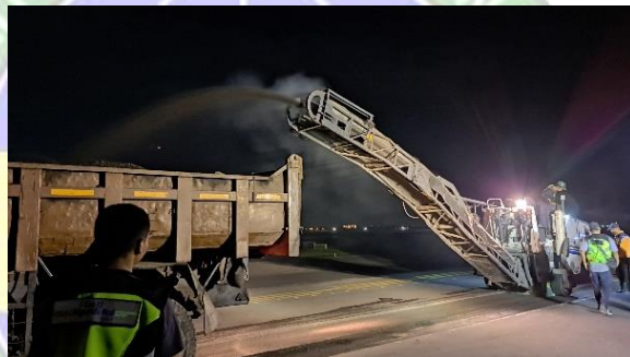
Gambar 4. 14 Pemotongan Aspal Menggunakan Cold Milling Machine (Sumber: Dokumentasi Penulis)
