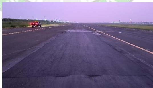
Gambar 4. 22 Hasil Pekerjaan Weakspot Pada Taxiway NP 7
