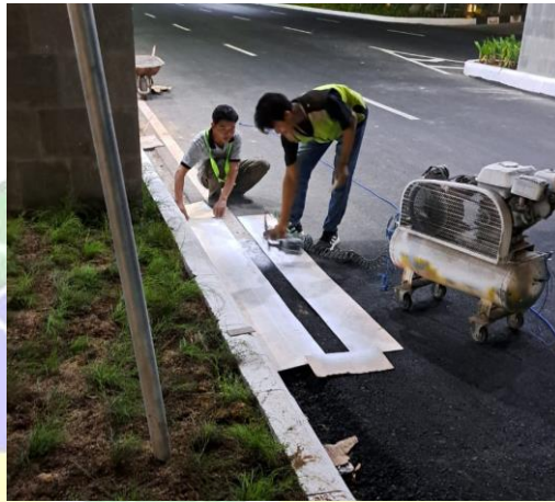
Gambar 4. 24 Pekerjaan Pengecatan Marka Jalan (Sumber: Dokumentasi Penulis)
