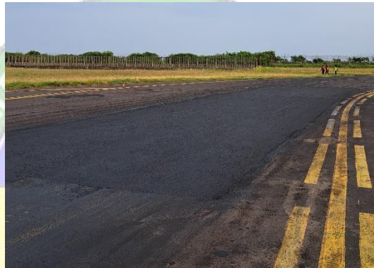
Gambar 4. 21 Hasil Pekerjaan Weakspot Pada Area Taxiway N7
