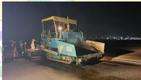
Gambar 4. 19 Proses Penghamparan Aspal Hotmix (Sumber: Dokumentasi Penulis)
