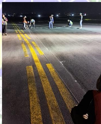
Gambar 4. 13 Pengukuran Dimensi Kerusakan (Sumber: Dokumentasi Penulis)
