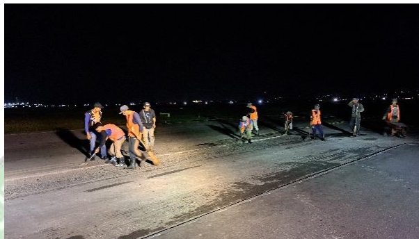
Gambar 4. 16 Proses Pembersihan Sisa Pembongkaran (Sumber: Dokumentasi Penulis)
