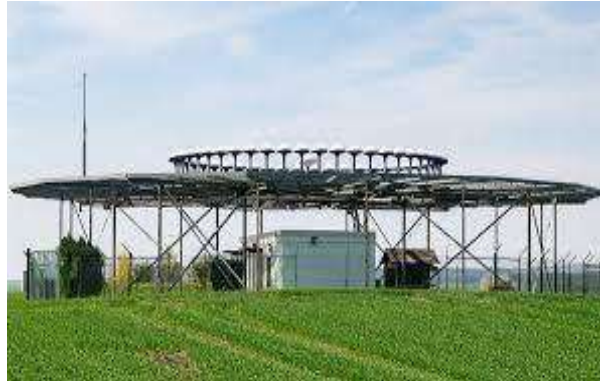
Gambar 3. 8 Antenna DVOR
