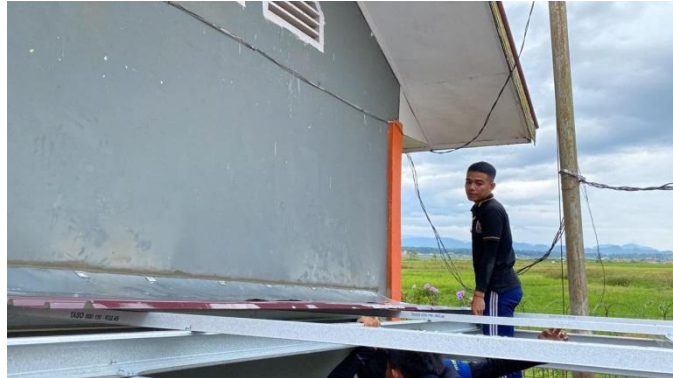
Gambar 4. 5 Pekerjaan Pemasangan Spandek Atap (Sumber: Dokumentasi penulis, 2024)
