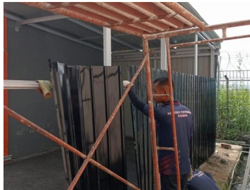
Gambar 4. 8 Pekerjaan Pemasangan Spandek Dinding (Sumber: Dokumentasi penulis, 2024)
