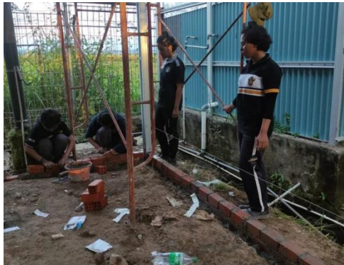
Gambar 4. 3 Pekerjaan Pemasangan Pondasi Batu Bata (Sumber: Dokumentasi penulis, 2024)
