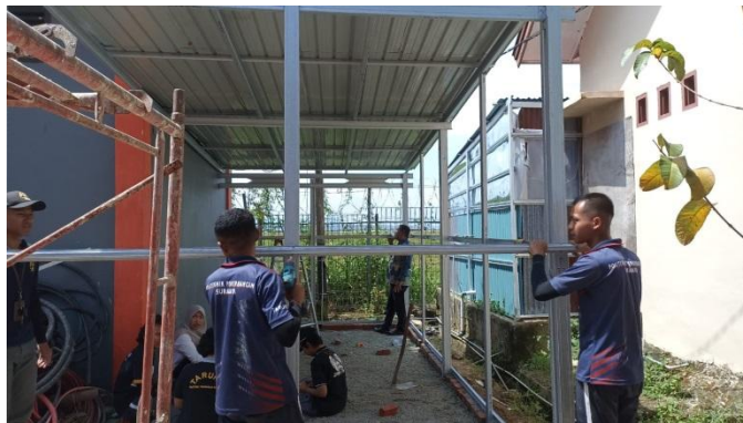
Gambar 4. 6 Pekerjaan Pemasangan Rangka Dinding (Sumber: Dokumentasi penulis, 2024)
