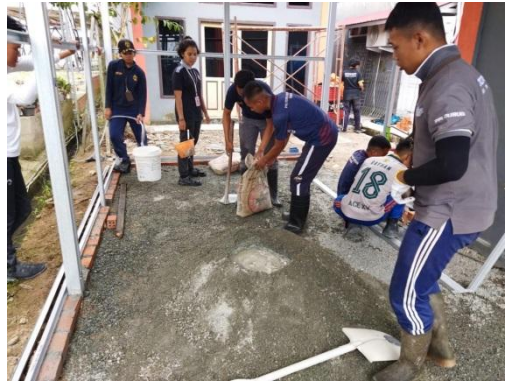
Gambar 4. 7 Pekerjaan Pengecoran Lantai (Sumber: Dokumentasi penulis, 2024)
