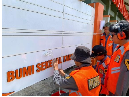
Gambar 4. 14 Pekerjaan Pemasangan Huruf (Sumber: Dokumentasi penulis, 2024)
