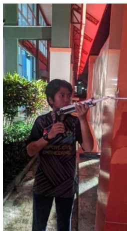
Gambar 4. 15 Pekerjaan Penambahan Sealant (Sumber: Dokumentasi penulis, 2024)
