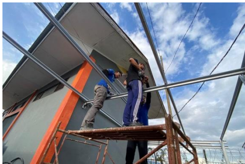
Gambar 4. 4 Pekerjaan Pemasangan Rangka Atap (Sumber: Dokumentasi penulis, 2024)
