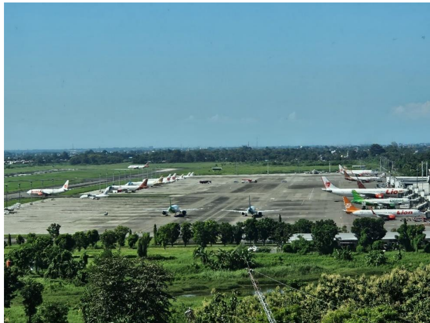
Gambar 4.2 Apron Bandar Udara Internasional Sultan Hasanuddin pada siang hari
